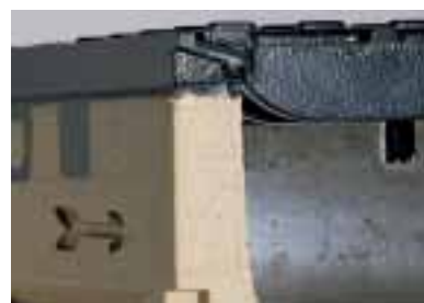
Gennemgående sikkerhedsfals helt til karmoverfladen
