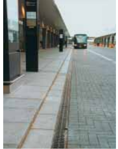
ACO DRAIN® S 100 K Terminal Kastrup lufthavn
