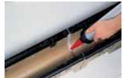
Fugning af sikkerhedsfalsen med ACO fugemasse
