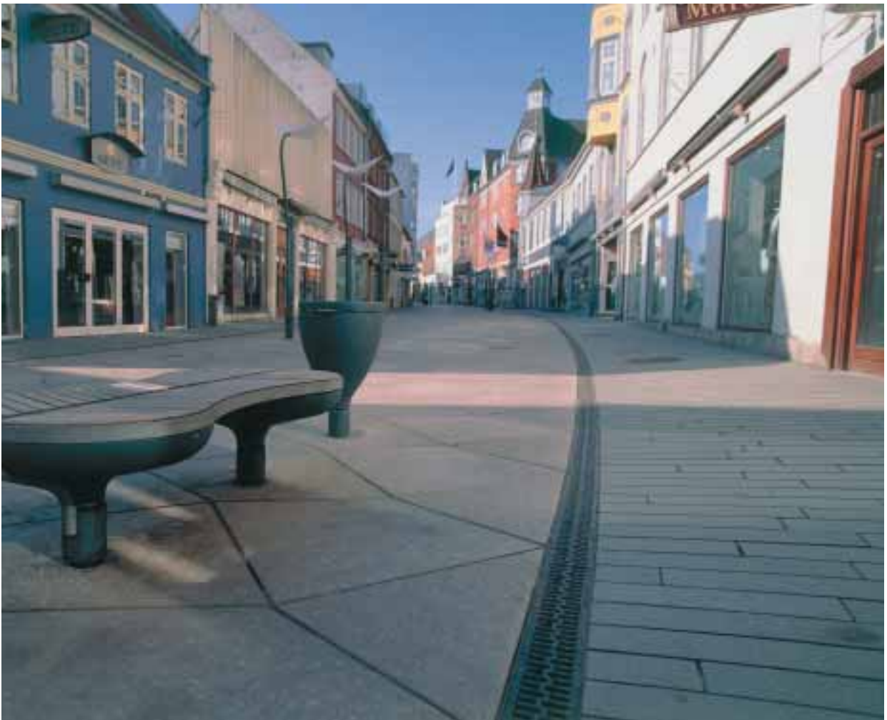
ACO DRAIN® S 100 K Vejle gågade
