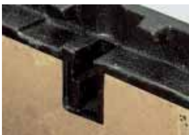
Låsetapper som forskydningsikring
