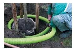
Das allseitig gelochte Baumerhaltungs-Rohr wird ringförmig im Wurzelbereich unter der Kronentraufe verlegt und mit dem T-Stück verbunden.
