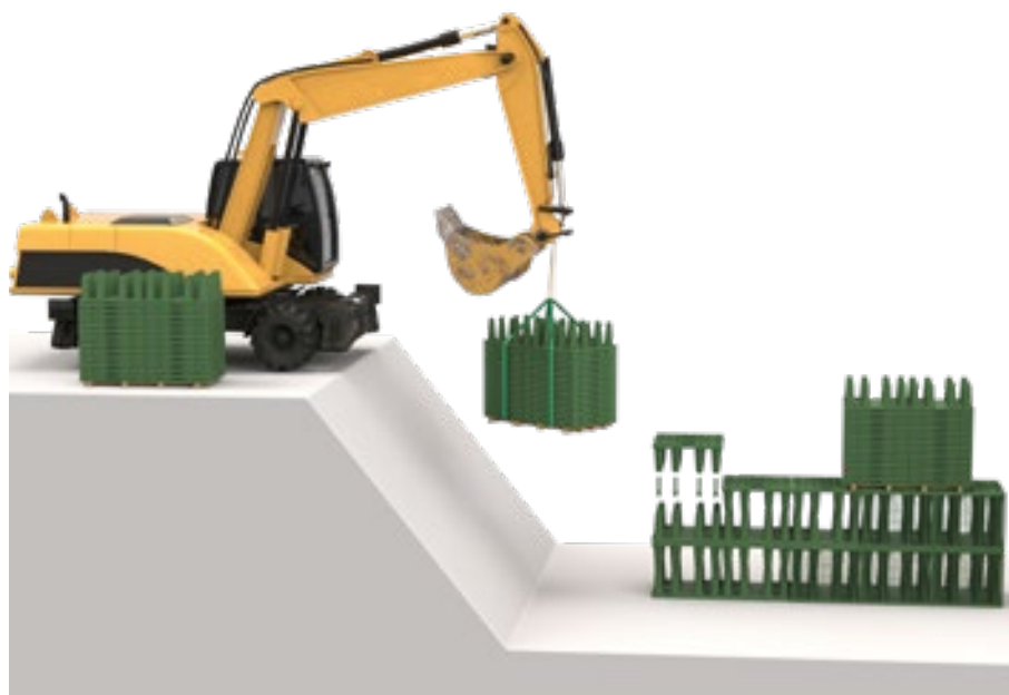
Montage i udgravningen
