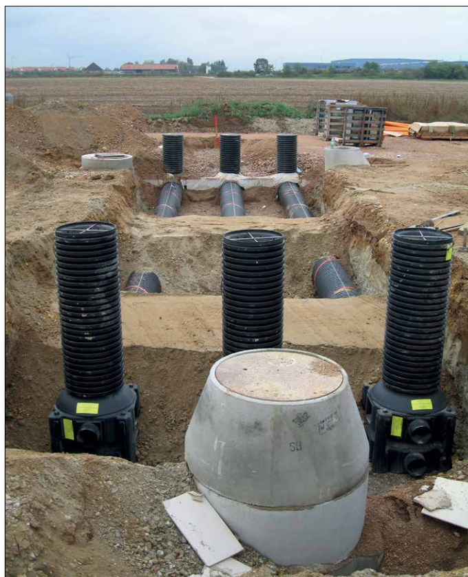
Anlæg med tre parallelle rør under udførelse.
